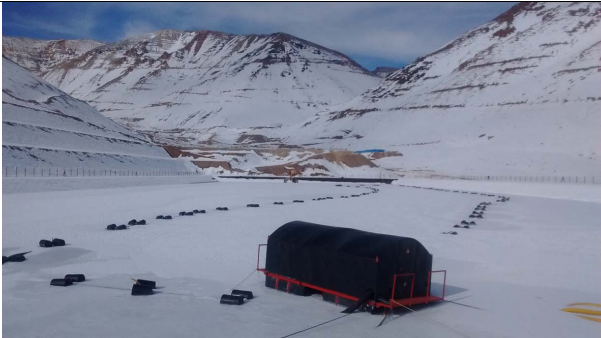
Imagen 6: Foto brindada por CMNSpA, de aprecia como la estructura Ventury no cumple misión de imposibilitar el congelamiento de las aguas de contacto en piscina de Acumulación N° 2.
